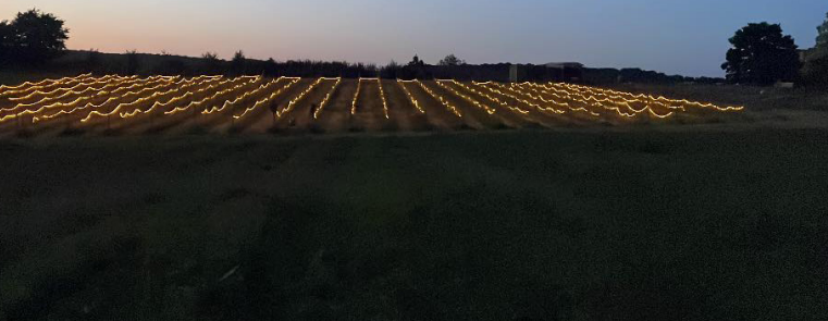
Système de câbles chauffants Frolight® au Domaine de Doriémont
